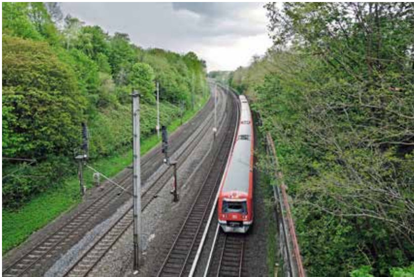
PSItraffic betrachtet das gesamte Liniennetz und übernimmt die dispositive Steuerung.
